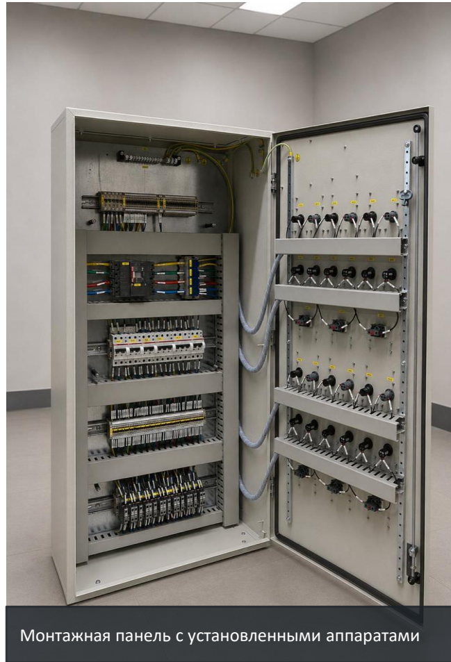
Распределительная панель 250 А, двухстороннее обслуживание
